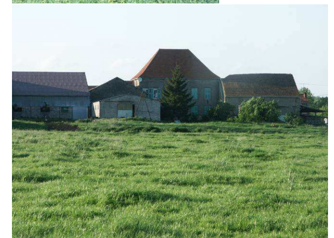
Petit fossé de la maison forte de Mouaville.
