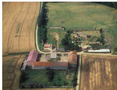
Ruines du château de Villers-aux-Bois, à Saint-Marcel, déblayées aujourd'hui.
